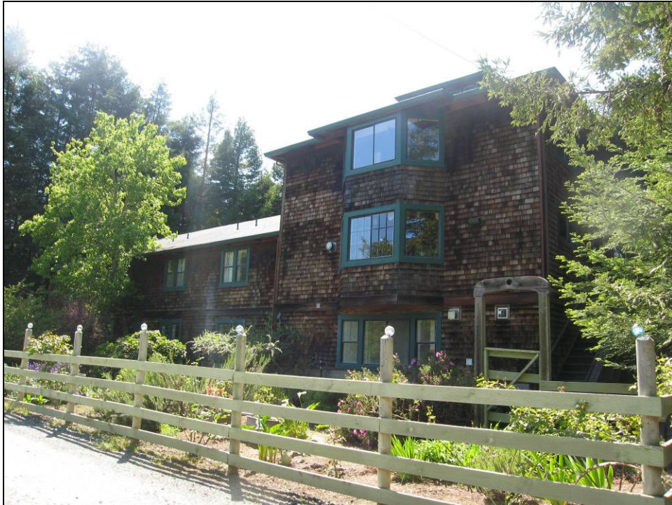
27 – 25233 Steelhead Blvd., APN 096-140-023
