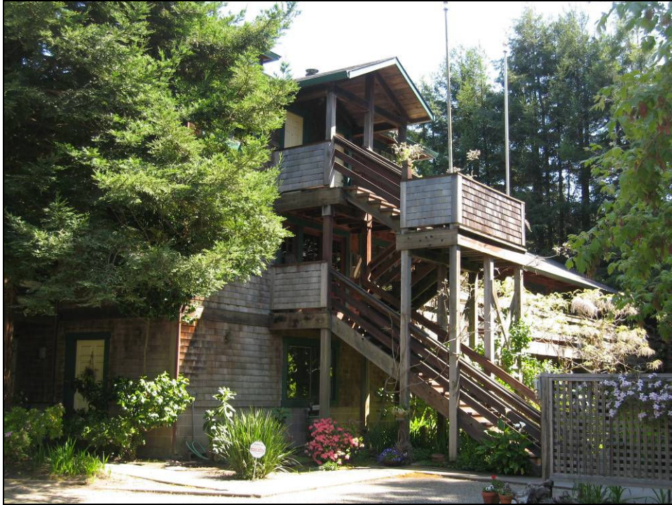
27 – 25233 Steelhead Blvd., APN 096-140-023
